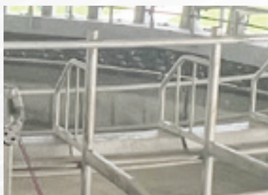
Divisores de cabezas Previene el "robo de alimento" entre establos
